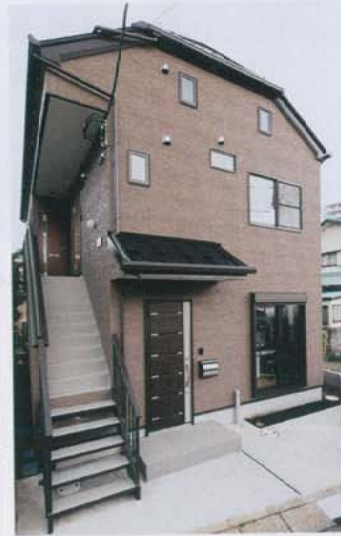
1階が住居、2階が賃貸。引っ越しを想定した外階段の幅など、プロの提案が詰まっている
