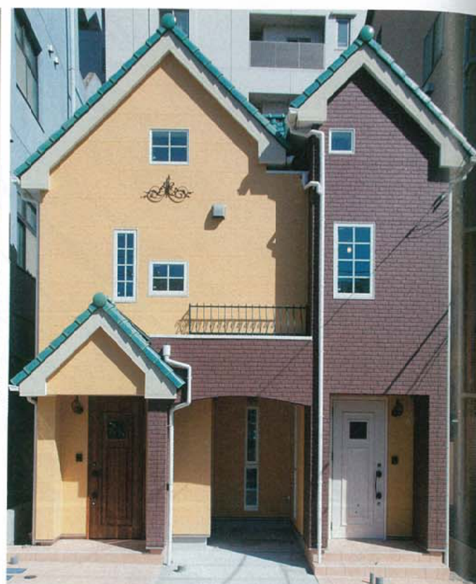
3方向を高層マンションが囲む立地。そのため高窓などを配置して採光には十分配慮した。洋瓦やアイアンの装飾などを用いた南欧風の外観も印象的（このページの写真はすべてN氏邸）
