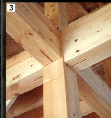
■ 下から見上げたワンスリット接合部
